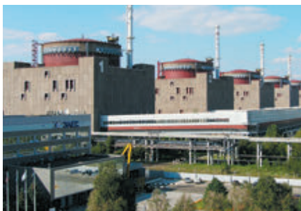
Рис. 18.2. Общий вид атомной электростанции (Запорожская АЭС)
