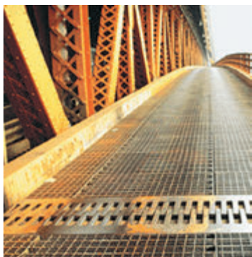
Рис. 2.6. Чтобы мост не выгибался во время жары и не разрушался в мороз, его делают из отдельных секций, соединенных специальными сочленениями (ряды зубцов смыкаются в жару и расходятся в мороз)
